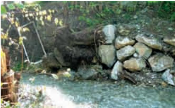
Zur Befestigung der Uferböschung wurden Steine und große alte Baumstämme eingebaut. Aus den Baumstämmen entsteht neuer Uferbewuchs
