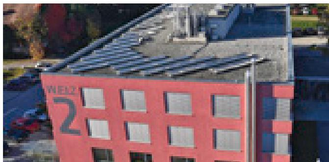
20 kWp-Photovoltaikanlage am Dach des W.E.I.Z. 2: Der 15 kWh-Blackout-resistente Energiespeicher und das multifunktionale Energie-Management-System befinden sich im Keller des Gebäudes.
